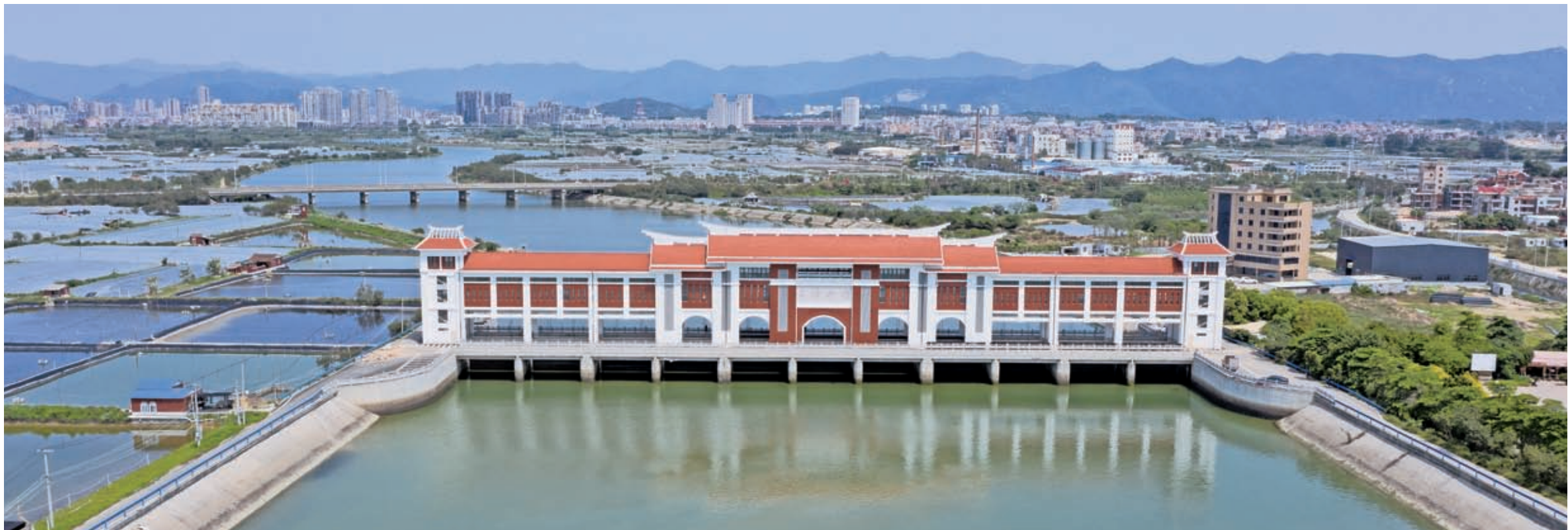
厦门同安石浔水闸
